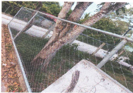
Foto 3: Reparación de tubo hg y malla galvanizada
