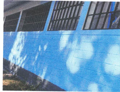
Foto 2: Pintura en muros exteriores e interiores
