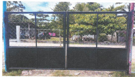
Foto 4: Fabricación e instalación de portón de metal de ingreso
