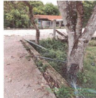
Foto 4: Reparación de tubo HG y Maya Galvanizada
