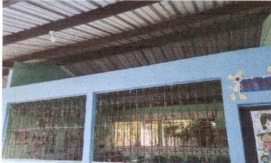
Foto 1: Sustitución de lamina, por lámina troquelada aluzinc calibre 26
