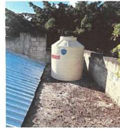
Foto 2: SUSTITUCIÓN DEPOSITO DE AGUA Renglón 18.2
