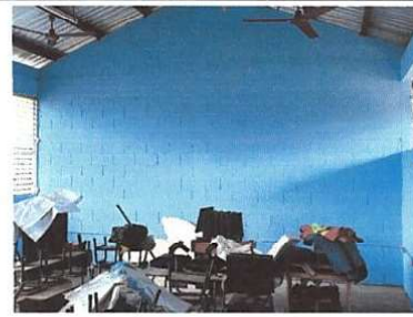
Foto 4: AULA PINTURA INTERIOR Renglón 9.1
