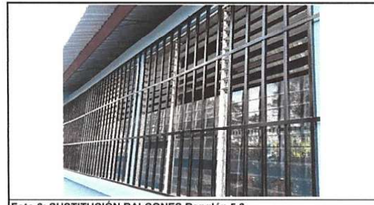
Foto 6: SUSTITUCIÓN BALCONES Renglón 5.6
