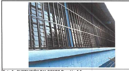
Foto 5: SUSTITUCIÓN BALCONES Renglón 5.6
