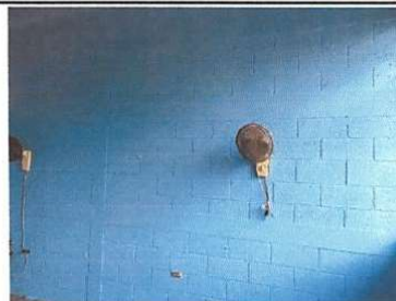
Foto 6: AULA PINTURA INTERIOR Renglón 9.1
