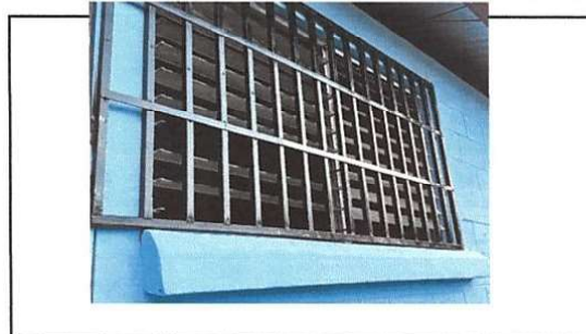
Foto 4: SUSTITUCIÓN DE BALCONES Renglón 5.6
