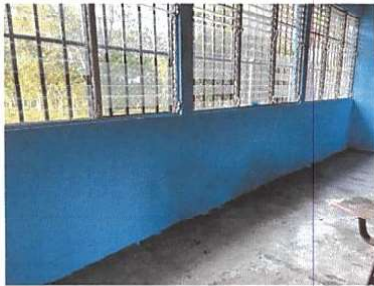
Foto 3: AULA PINTURA INTERIOR Renglón 9.1
