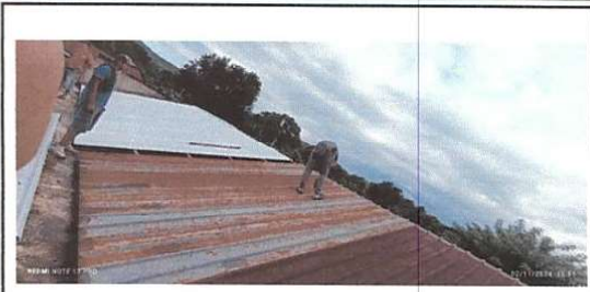
Foto 1: SUSTITUCIÓN LÁMINA Renglón 1.1
