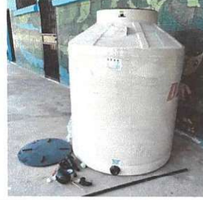
Foto 2: SUSTITUCIÓN DEPOSITO DE AGUA Renglón 18.2
