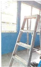
Foto 3: AULA PINTURA INTERIOR Renglón 9.1
