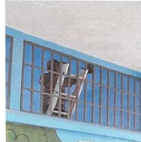
Foto 4: AULA PINTURA INTERIOR Renglón 9.1
