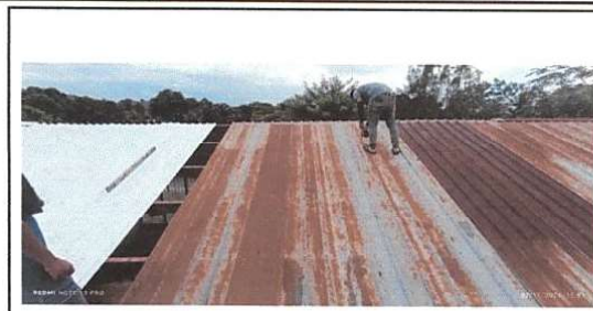
Foto 2: SUSTITUCIÓN DE LÁMINA Renglón 1.1
