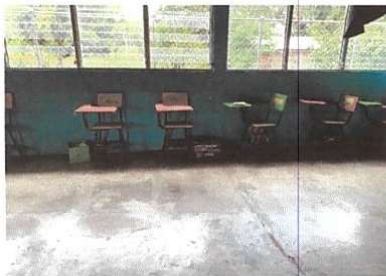
Foto 3: AULA PINTURA INTERIOR Renglón 9.1
