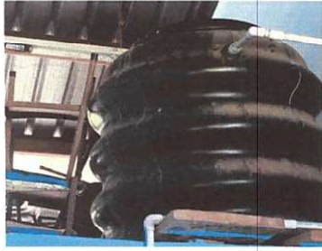
Foto 1: SUSTTUCIÓN DEPOSITO DE AGUA Renglón 18.2
