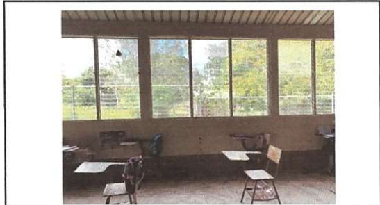
Foto 2: AULA PINTURA INTERIOR Renglón 9.1
