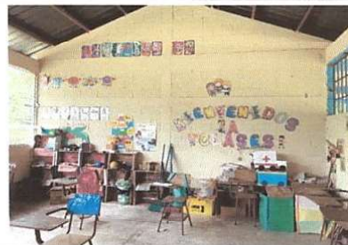
Foto 6: AULA PINTURA INTERIOR Renglón 9.1
