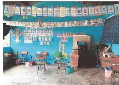
Foto 4: AULA PINTURA INTERIOR Renglón 9.1
