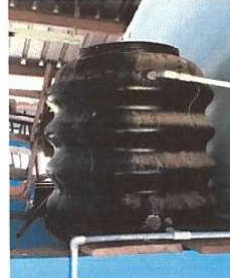
Foto 2: SUSTITUCIÓN DEPOSITO DE AGUA Renglón 18.2
