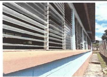
Foto 6: SUSTITUCIÓN BALCONES Renglón 5.6
