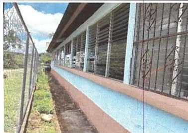
Foto 5: SUSTITUCIÓN BALCONES Renglón 5.6
