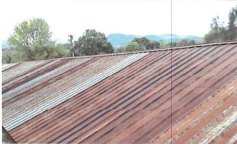
Foto 3: SUSTITUCIÓN DE CAPOTE Renglón 1.2
