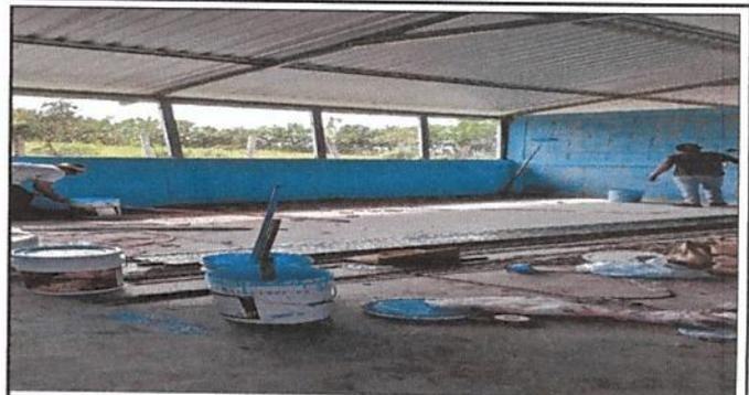
Foto 2 Renglon 1.1 Sustitución de lamina por lamina troquelada de calibre 26
