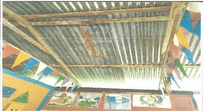
Foto 1 Renglon 2.2 Sustitución de estructura de soporte de madera, por metal
