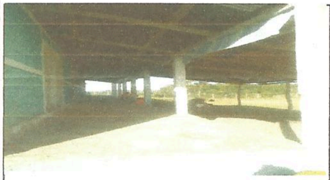
Foto 3 Renglon 6.2, Reparacion de piso de cemento liquido
