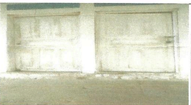
Foto 4 Renglon 4.3, sustitucion de puertas en modulos
