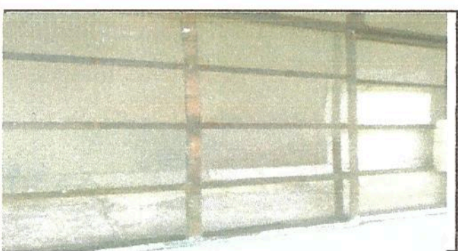
Foto 5 Renglon 19.2, Fabricacion e instalacion de balcon de hierro en ventana
