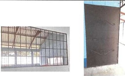
Foto 6: Balcones y puertas
