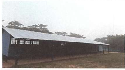
Foto 2: Láminas y capotes sustituidos
