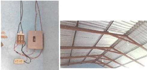
Foto1: Reparación de sistema eléctrico
