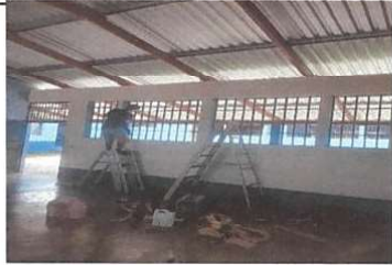
Foto1: Balcones en mal estado
