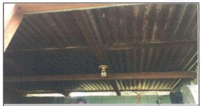
SUSTITUCION DE ESTRUCTURA DE MADERA POR METAL
