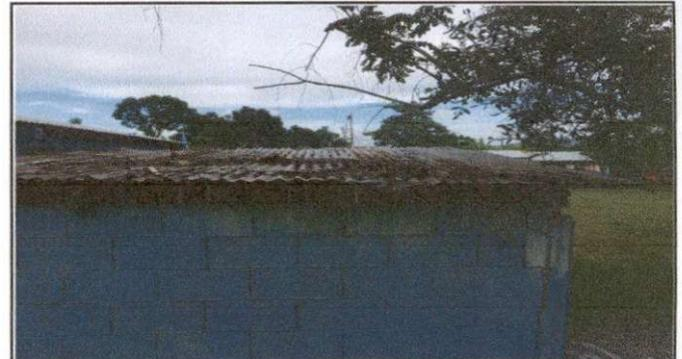
SUSTITUCION DE LAMINA, POR LAMINA TROQUELADA ALUZIN CALIBRE 26
