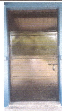
Foto 4: Mantenimiento realizados en puertas
