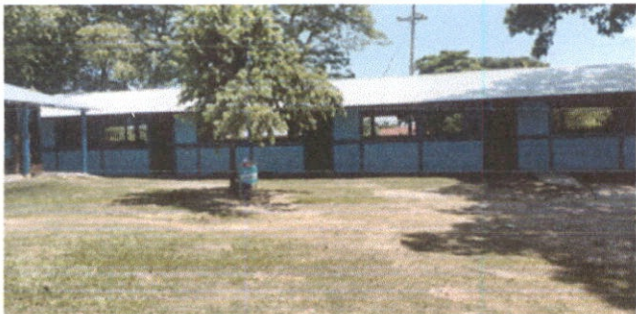
Foto 1: Lámina troquelada aluzinc calibre 26
