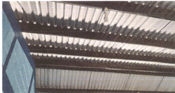
Foto 2: Lámina troquelada aluzinc calibre 26, nueva e instalada
