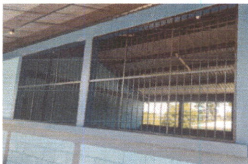
Foto 5: Estructura de ventana nueva (Balcon)
