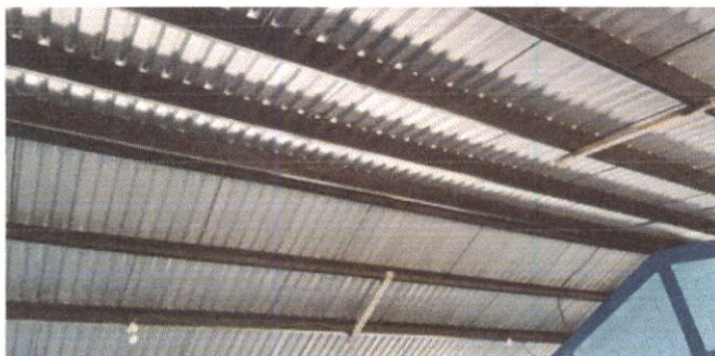
Foto 3: Estructura de soporte de metal, mantenimiento realizado
