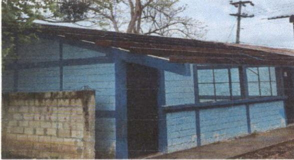
Foto 1: Desmontaje de lamina
