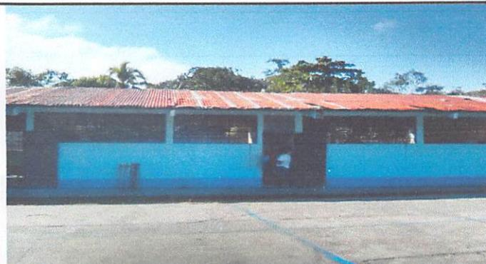
Foto2: Cambio de estructura de techo por lamina troquelada de 26 pies
