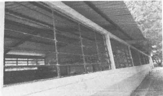
priorizacion 3 Fabricacion e instalacion de balcones de hierro en ventanas.
