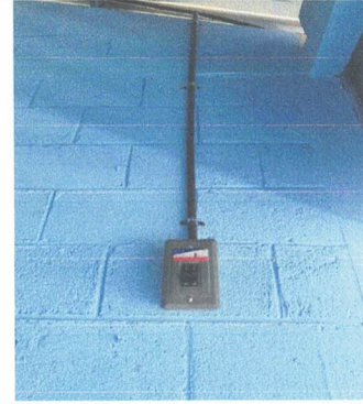
FOTO 8: Reparación de cableado eléctrico.
