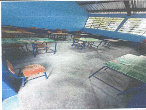
FOTO 9: Reparación de cemento líquido.
