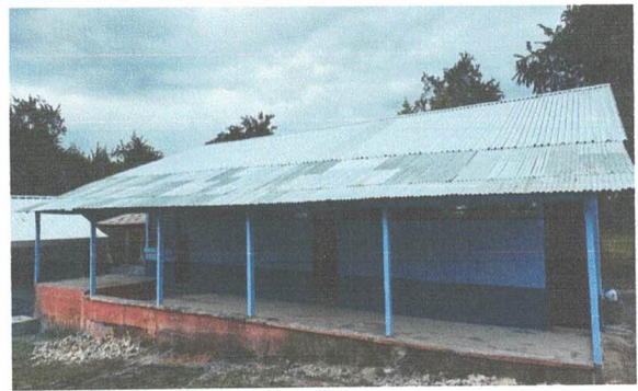
FOTO 10: Instalación de lámina troquelada Aluzinc.
