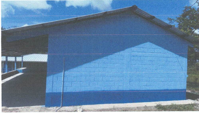
FOTO 7: Pintura en muros exteriores e interiores
