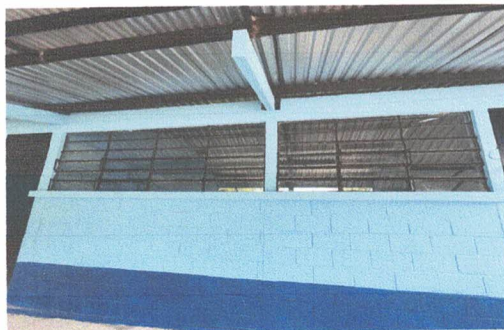
FOTO 5: Mantenimiento a estructura de metal por ventana
