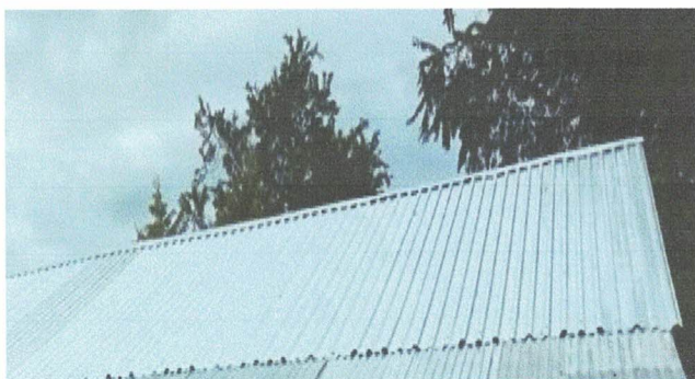
FOTO 3. Sustitución de capote de lámina troquelada
