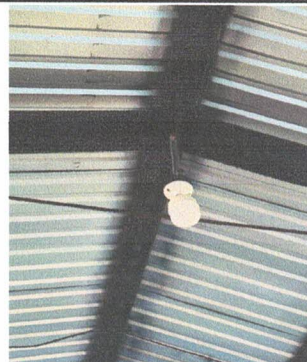
FOTO 8: Reparación de cableado eléctrico.
