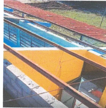
FOTO 2: Sustitución de estructura de soporte de madera por metal
