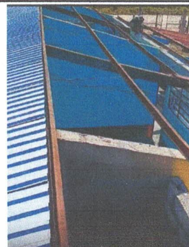
FOTO 10: Instalación de lámina troquelada Aluzinc.
