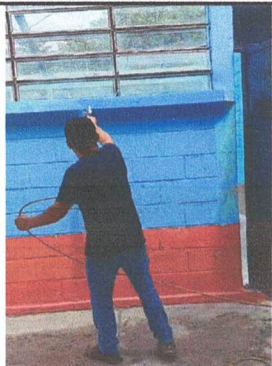
FOTO 7: Pintura en muros exteriores e interiores
