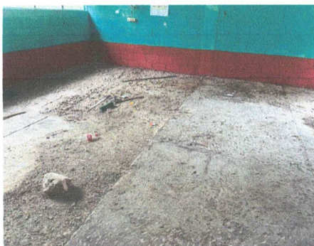
FOTO 9: Reparación de cemento líquido.
