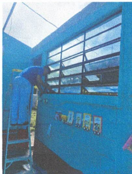
FOTO 5: Mantenimiento a estructura de metal por ventana
