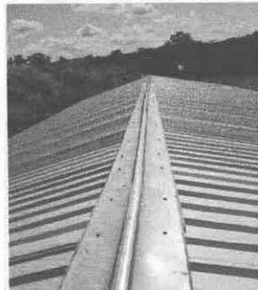
Foto 2: Sustitución de capote de lámina para lámina troquelada
