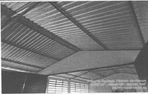
Foto 1: Sustitución de durallita, por lámina troquelada aluzinc calibre 26
