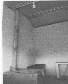
Foto 10: Sustitución de estufa rural (completa) incluye chimenea y plancha de metal
