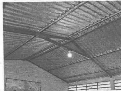
Foto 6: Reparación de cableado eléctrico
