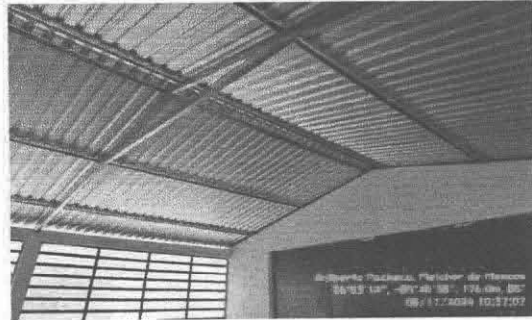
Foto 8: Desinstalación de duralita existente.
