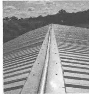
Foto 2: Sustitución de capote de lámina para lámina troquelada
