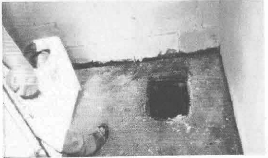
Foto 9: Instalación de letrina o cemento plastico
