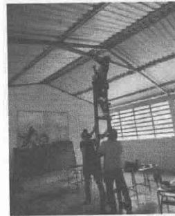
Foto 6: Reparación de cableado eléctrico
