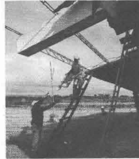
Foto 8: Desinstalación de duralita existente.
