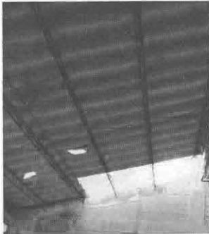
Foto 3: Sustitución de estructura de soporte de metal, por metal
