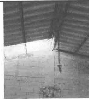
FOTO 6: Reparación de cableado eléctrico
