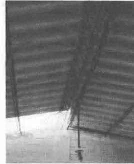
Foto 2: Sustitución de capote de lámina para lámina troquelada
