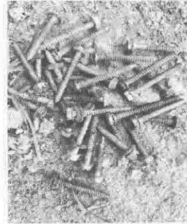
Foto 4: Sustitución de elementos de fijación
