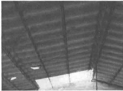
Foto 1: Sustitución de duralita, por lámina troquelada aluzinc calibre 26
