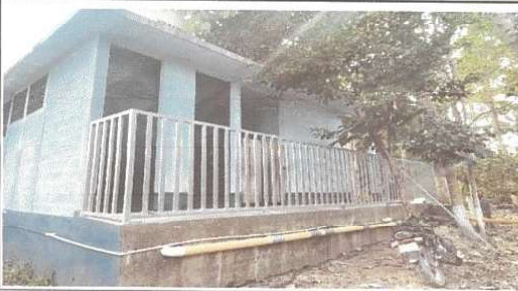
FOTO 4. CAMBIO DE TUBERIA
