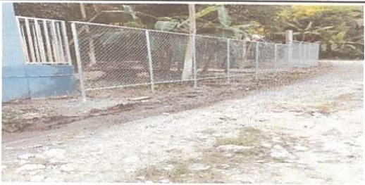
FOTO 3. CAMBIO DE CERCO.
