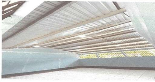
FOTO 1. PISO Y ENERGÍA ELECTRICA.
