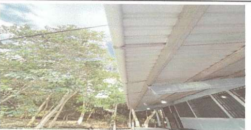
FOTO 5. CAMBIO DE BALCONES
