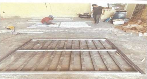
FOTO 3. FABRICACIÓN DE BALCONES
