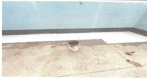
FOTO 1. SUSTITUCIÓN DE PISO CERAMICO
