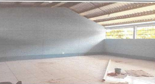
FOTO 4. PINTURA DE INTERIOR Y EXTERIOR
