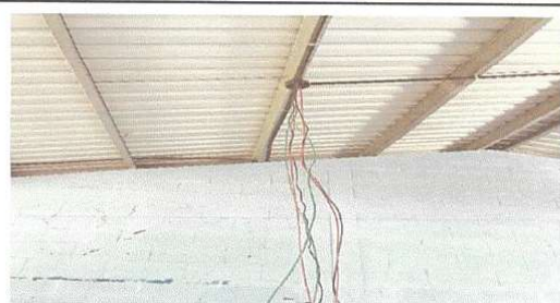
FOTO 2. INSTALACIÓN DE CABLEADO ELECTRICO
