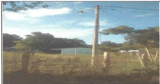
Foto 10 Renglon 19.14 Instalacion de Acometida electrica
