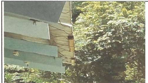
FOTO 09 Renglon 17.30 Sustrucion de lampaas tipo led
