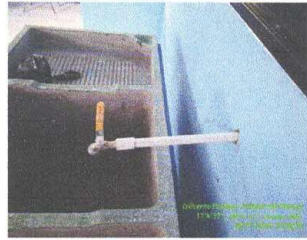
Foto 7: Sustritiución de tubería línea principal (Red de agua potable)
