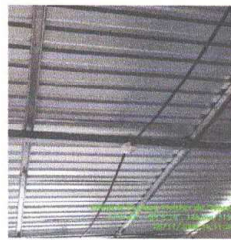
Foto 8: Reparación sistema eléctrico
