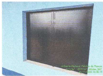
Foto 9: Fabricación e instalación de balcones
