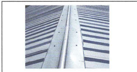
Foto 3: Sustitución de elementos de fijación
