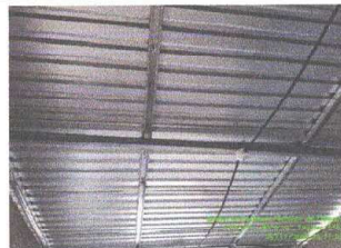
Foto 11: Instalación de lámina troquelada aluzinc
