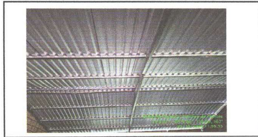
Foto 10: Instalación de lámina troquelada aluzinc
