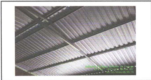
Foto 9: Instalación de estructura portante de metal
