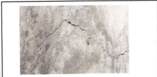
Foto 3: Sustrucción de piso de torta de concreto
