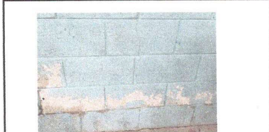
Foto 4: Pintura en muros exteriores e interiores
