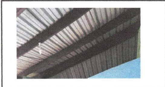
Foto 2: Sustrucción de estructura de soporte de metal, por metal
