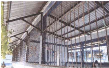
Foto 3: Mantenimiento de Balcones
