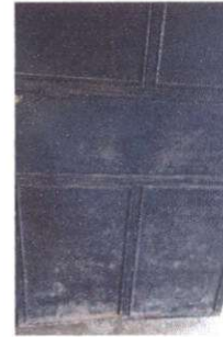
Foto 2: Mantenimiento a puertas de modulo
