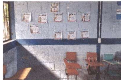
Foto 4: Pintura de Muros exteriores e interiores
