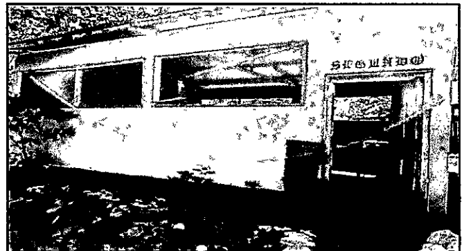
Foto 4: Ventanales de ambos lados y puerta frontal en mal estado.
