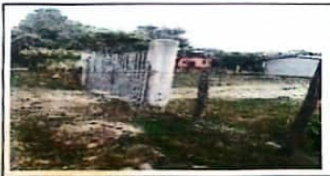
Foto 5 Mantenimiento de portones de metal
