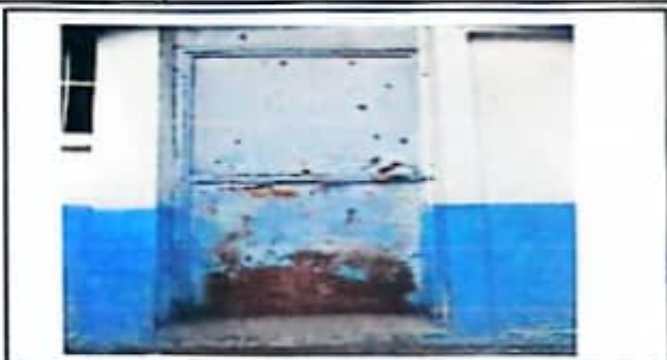
Foto 2 Sustitución de puerta
