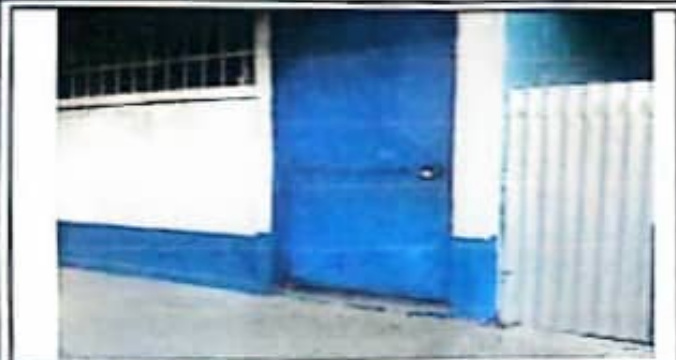
Foto 1 Mantenimiento a estructura (lijado, cambio de tubo, cepillado, sujeciones, aplicación de pintura)
