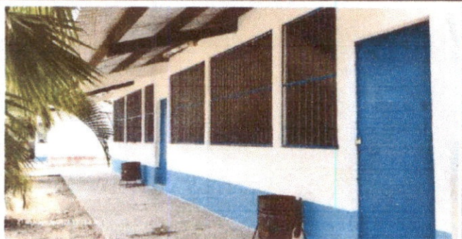
Foto 3: posterior al mejoramiento de balcones, pintura y energía eléctrica.
