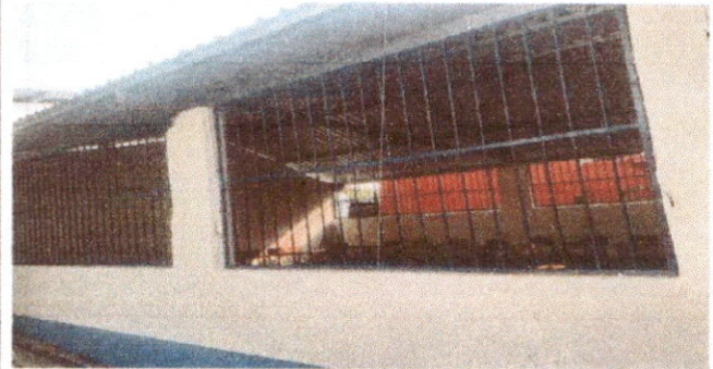
posterior a la instalación de estructura de techo, balcones, puertas, pintura.
