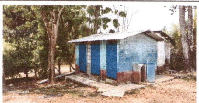
Foto 4: posterior a la reparación de servicios sanitarios, puertas e maderas.
