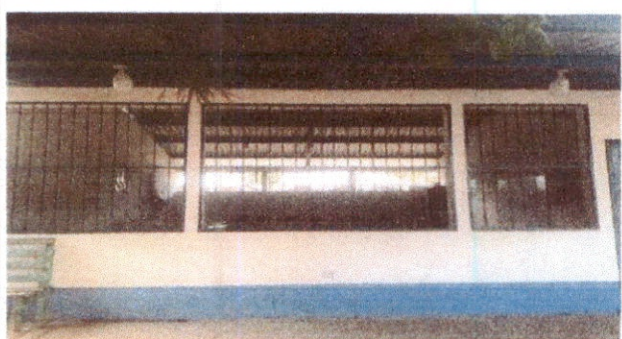
posterior a la instalación y mejoramiento de balcones, pintura, energía eléctrica y demás Accesorios.
