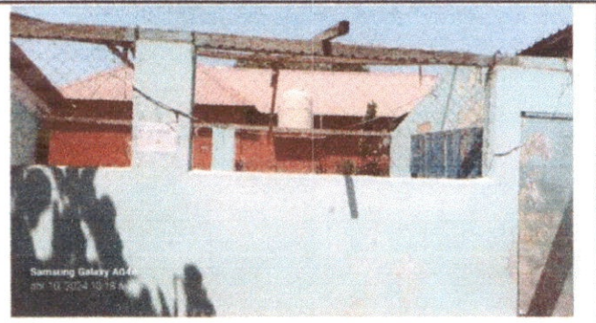
Foto 2: Durante la desarmadura para instalación de ventanas, balcones y puertas.
