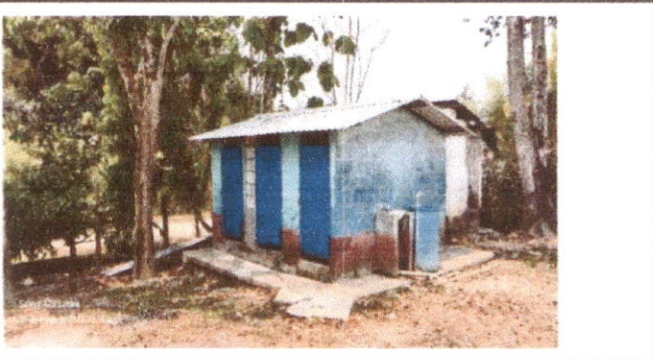
Foto 4: Durante la reparación de servicios sanitarios e inodoro.
