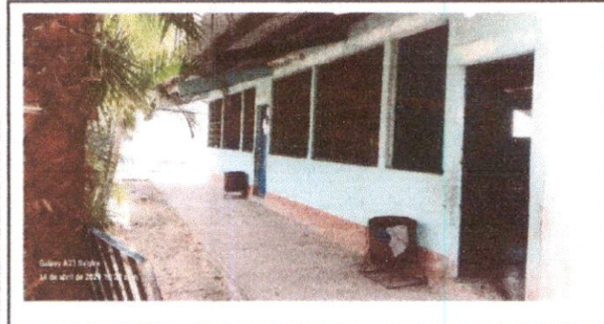
Foto 3: Durante la desarmadura de nicayas y balcones para el mejoramiento de balcones, pintura y energía.
