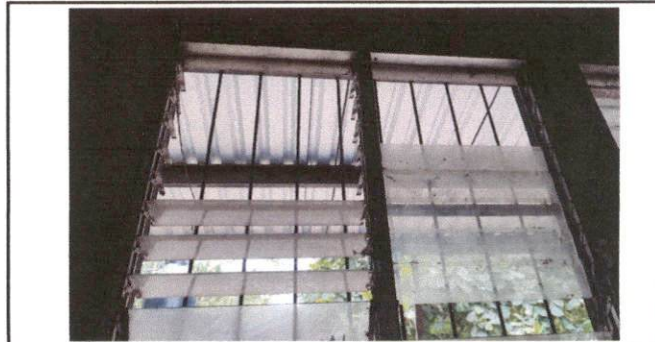
Foto 6: Ventanas: Sustitución de Percianas
