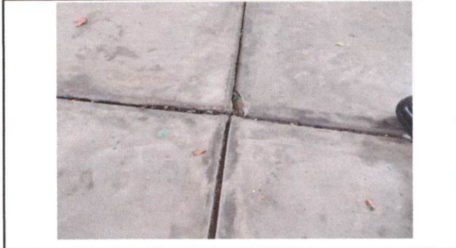
Foto 2: Susstitución de piso de cemento liquido
