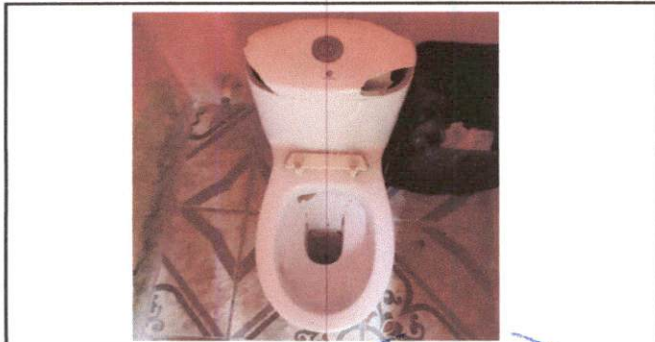
Foto 5: Servicios sanitarios y sus accesorios
