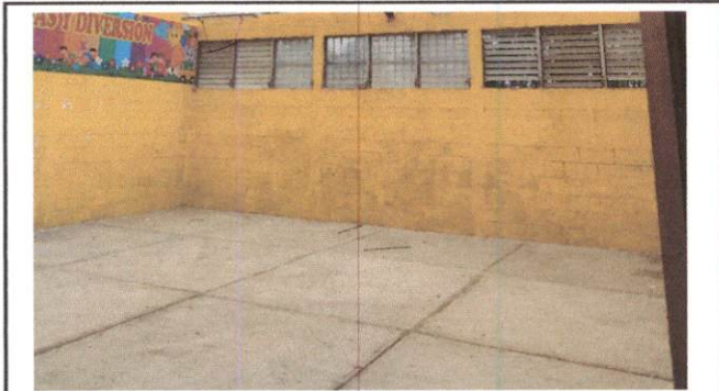
Foto 3: Pintura de muros exteriores e Interiores
