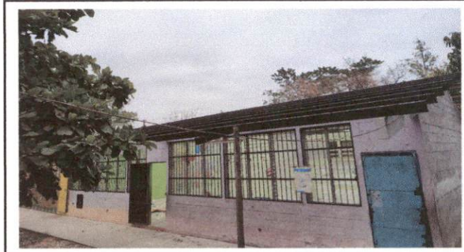
Foto 4: Cubierta de Lamina
