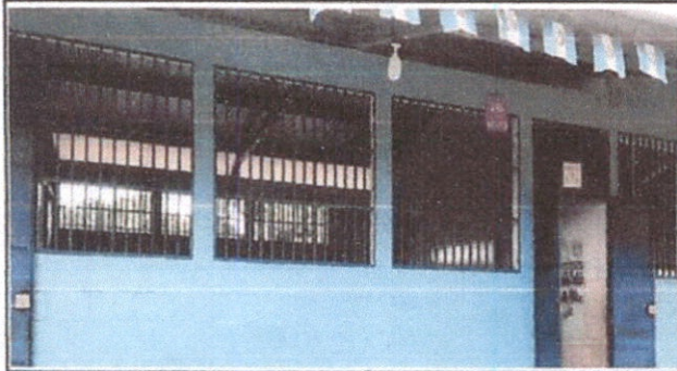
Foto 1 : Sustrucción de chapas
