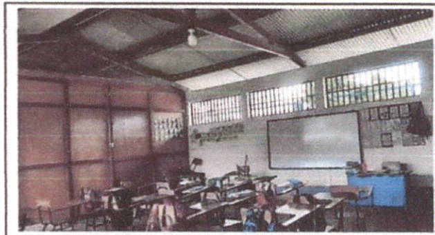
Foto 4 : Sustrucción de lámpara Led a foco ahorradores
