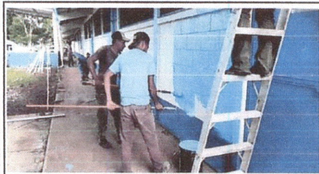
Foto 3 : Pintura en muro exteriores e interiores
