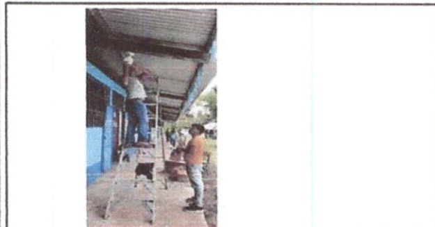
Foto 5 : Sustitucion de focos ahorradores
