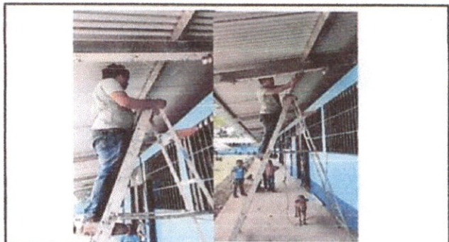
Foto 4 : Sustitucion de lámpara Led a foco ahorradores
