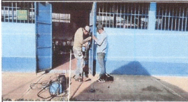
Foto 1 : Sustitucion de chapas
