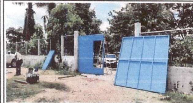
Foto 7 Fabricacion e Instalacion de porton de metal de ingreso
