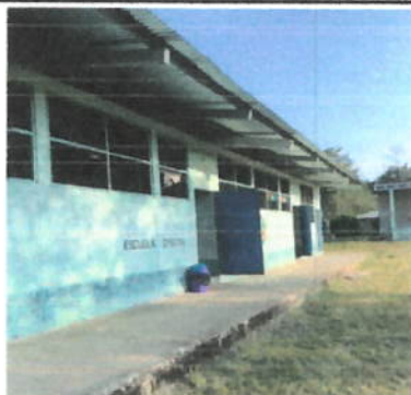
Foto 1: FACHADA PRINCIPAL DEL ESTABLECIMIENTO.
