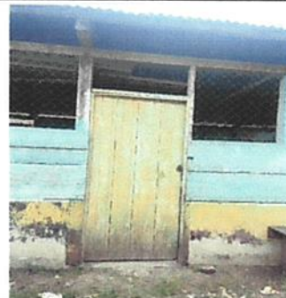
Foto 6: Aquí se evidencia la puerta en malas condiciones.
