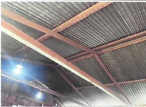
Foto 3: En esta fotografía se puede evidenciar la parte interior del techo.
