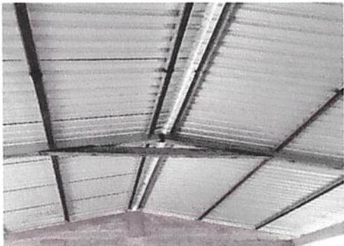
Foto 3: sustitución de estructura de lámina, por lámina troquelada aluzinc calibre 26
