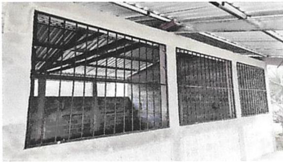
Foto 5: sustición de balcones de metal
