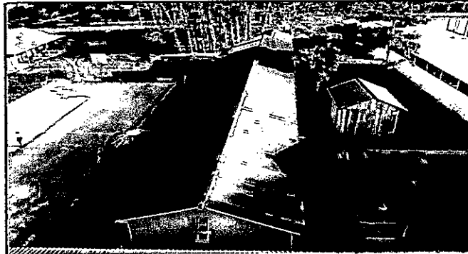
FOTO 2: Vista de la parte externa superior del módulo II, se aprecia que necesita cambio de techo.
