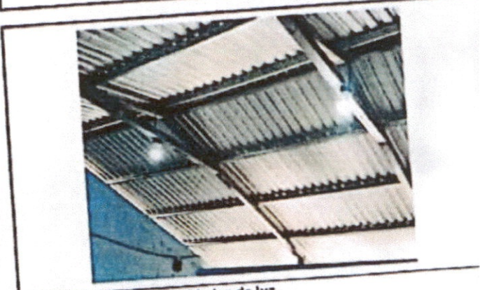
Foto 10: Instalación de unidades de luz
