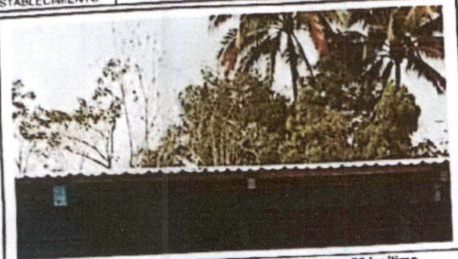
Foto 1: Instalación de lámina troquelada aluzinc calibre 26 legítimo
