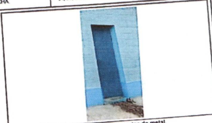
Foto 8: Mantenimiento a estructura de puertas de metal.
