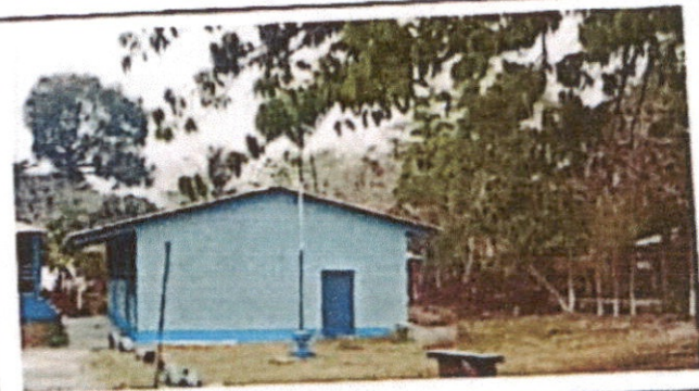
Foto 4: Pintura en muros de exterior e interior
