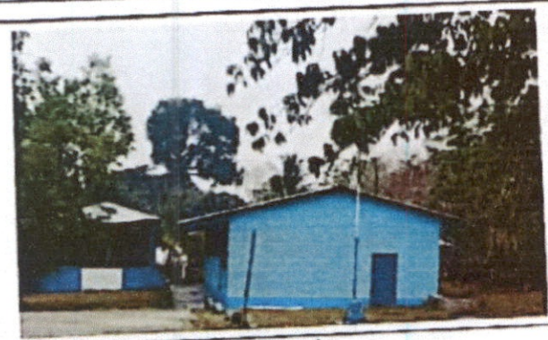
Foto 3: Repello en muro exterior en módulo
