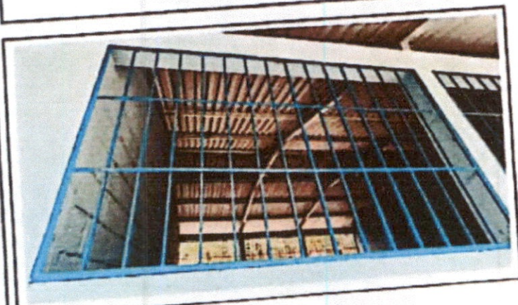
Foto 9: Instalación de Balcones
