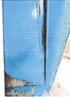
Foto 8: Mantenimiento de estructura de puerta de metal.
