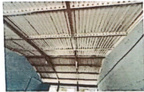
Foto 10: Instalación de unidades de luz
