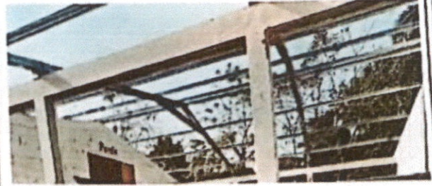
Foto 2: Instalación de estructura de soporte de metal.
