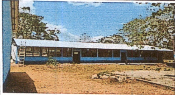
Foto1: Cubierta de lámina nueva
