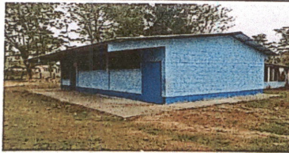
Foto 5: Torta de concreto terminada.
