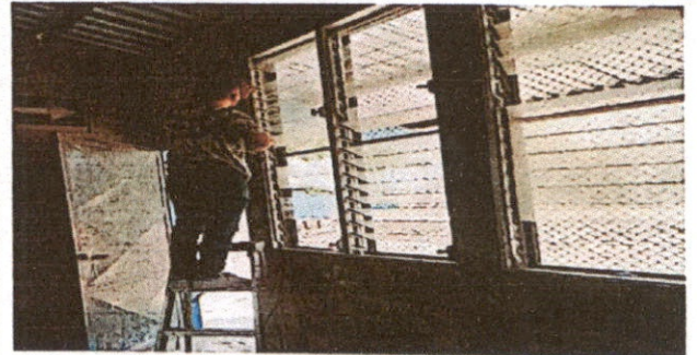
Foto 4: Sustitución de persianas en mal estado
