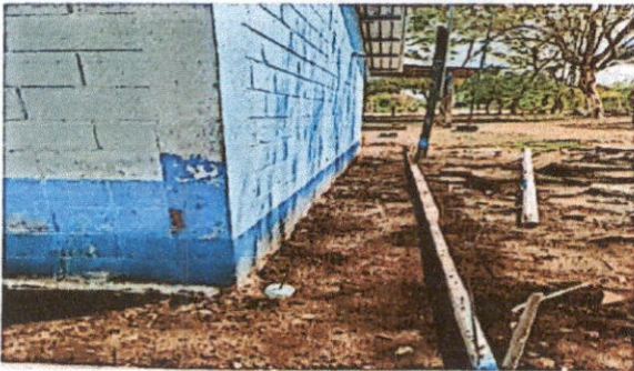
Foto 5: Inicio de la sustitución del piso de torta.
