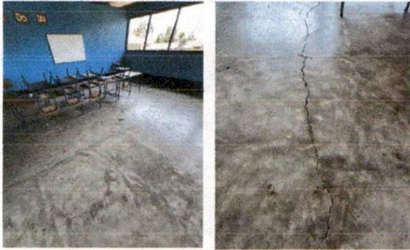
Foto 1: EL SUELO DE LAS AULAS Y EL PASILLO PRESENTAN FRACTURAS O LEVANTAMIENTO.
