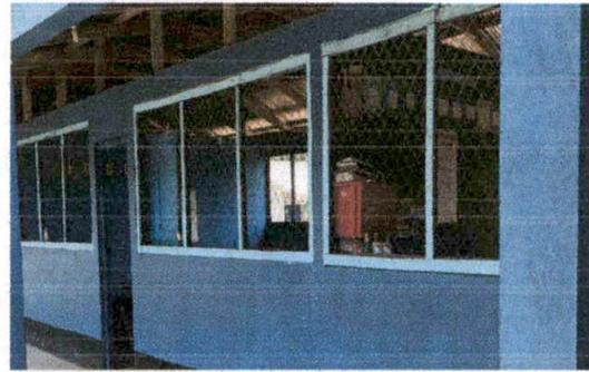
Foto 2: LOS MARCOS DE LAS VENTANAS DE LAS AULAS MUESTRAN GRIETAS Y HUMEDAD EN LA MADERA.
