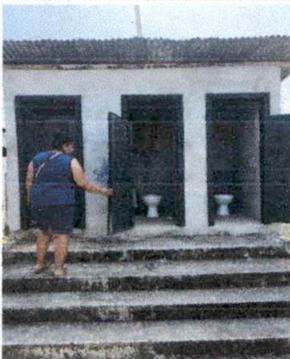
Foto 3: LAS PUERTAS DE LOS BAÑOS TIENEN BISAGRAS EN MAL ESTADO Y NO CUENTAN CON CERRADURA.
