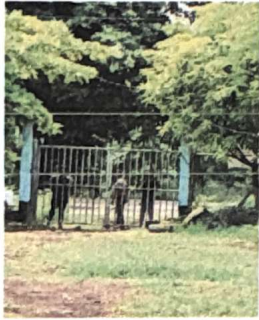
Foto 1: REMOZAMIENTO EN PORTON DE INGRESO
