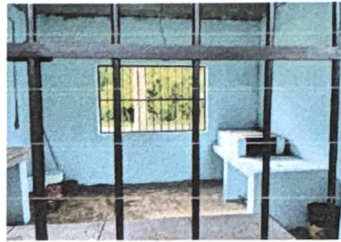
Foto 8: INSTALACION DE POLLETON
