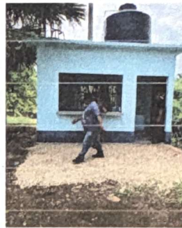
Foto 10: PINTURA EN FINALIZADA EN COCINA
