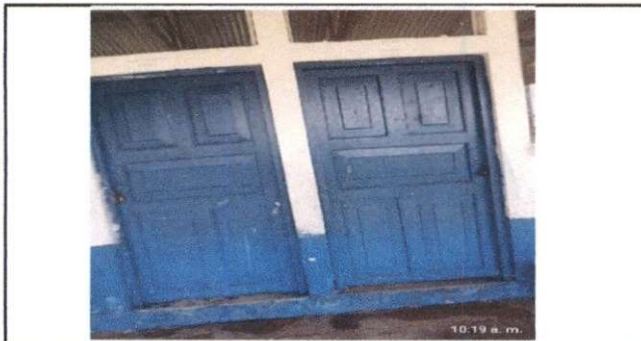
Foto 5: Sustitución de Puerta ✓
