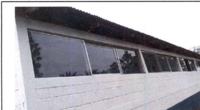
Foto 3: Fabricación e instalación de ventana-balcon de metal ✓
