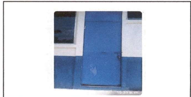
Foto 6: Sustitución de Puerta ✓
