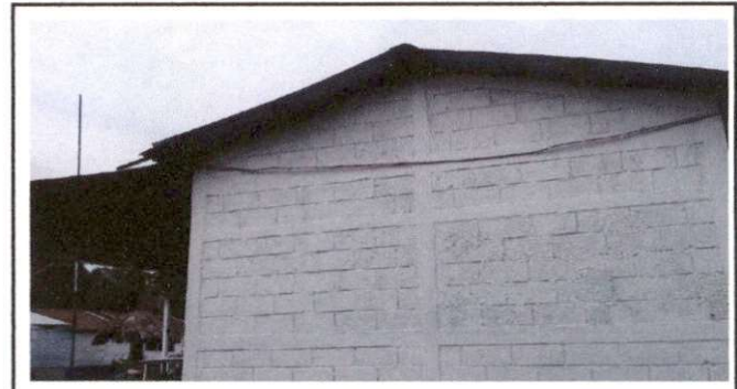
Foto 4: Pintura en muros exteriores e interiores ✓
