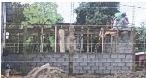
Foto 5: LEVANTADO DE MURO
