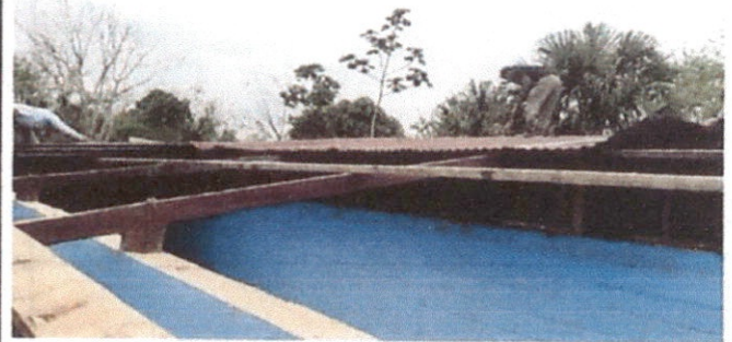
Foto 2: Desmontando el techo del aula 2
