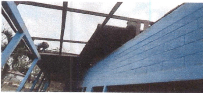
Foto 1: Desmontando el techo de aula 1
