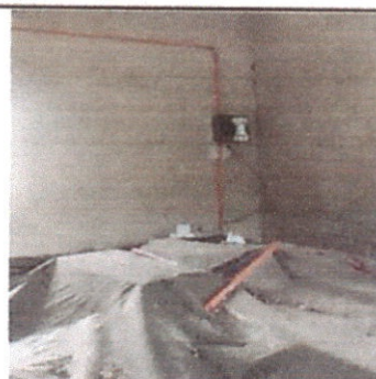
Foto 6: intalando tablero de 6 polos en el aula 1
