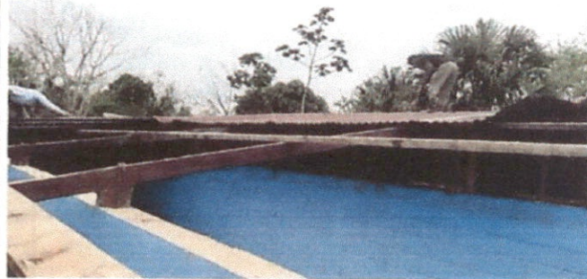
Foto 2: Desmontando el techo del aula 2
