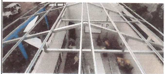
Foto 4: Instalando soportes para la lamina troquelada Aula 4
