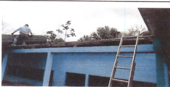
Foto 3: desmontando el techo del aula 3
