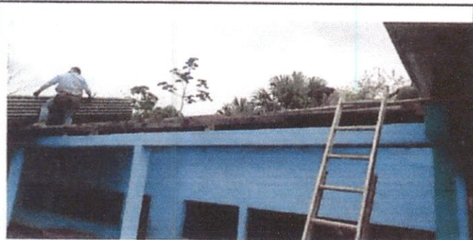
Foto 3: desmontando el techo del aula 3
