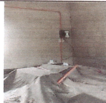
Foto 6: intalando tablero de 6 polos en el aula 1
