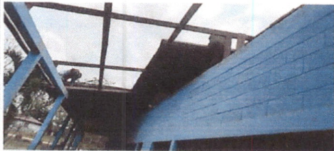
Foto 1: Desmontando el techo dl aula 1
