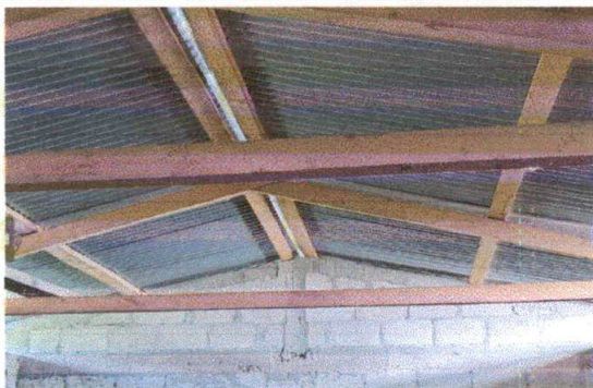
Foto 5: VISTA INTERIOR DE MODULO 1, SE VISUALIZA LA FLEXIÓN DE LOS ELEMENTOS PORTANTES DE LA CUBIERTA
