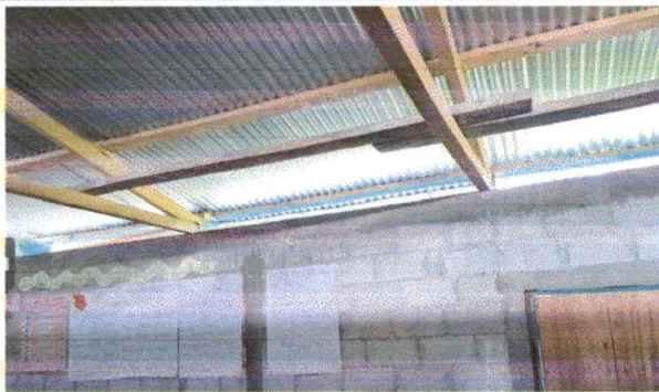
Foto 11: VISTA INTERIOR DE MODULO 1, SE OBSERVA LOS REFUERZOS QUE SE LE HAN INSTALADO A LA ESTRUCTURA PORTANTE
