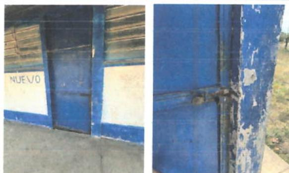
Foto 4: AULAS, LAS PUERTAS DE METAL TIENE BISAGRAS EN MAL ESTADO Y PASADORES QUE NO OFRECEN SEGURIDAD ADECUADA.
