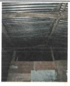
Foto 4: AULA (C), LA ESTRUCTURA DEL TECHO ESTÁ DETERIORADA, CON VIGAS DE MADERA PODRIDA Y LÁMINAS QUE PRESENTAN FILTRACIONES.
